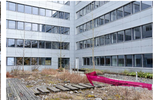
④ Auf der rechten Seite befindet sich der Eingang zur «AMM EAR».
